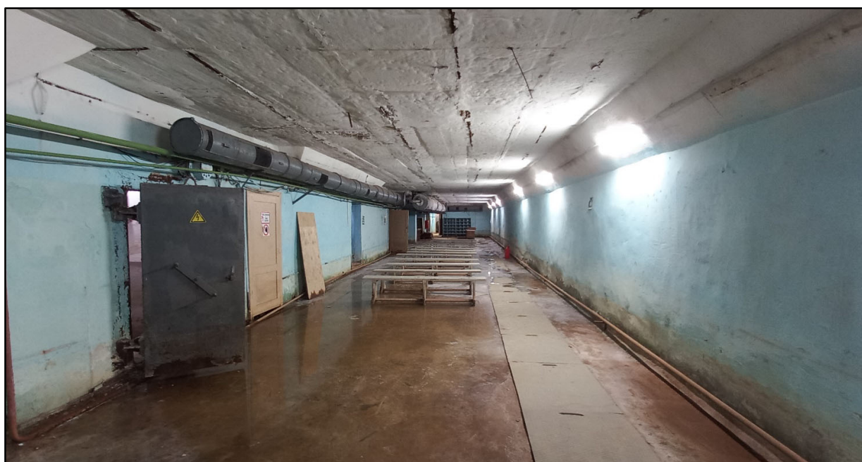
Фото 1, 2. Общий вид помещения в осях 36-37/В-К
