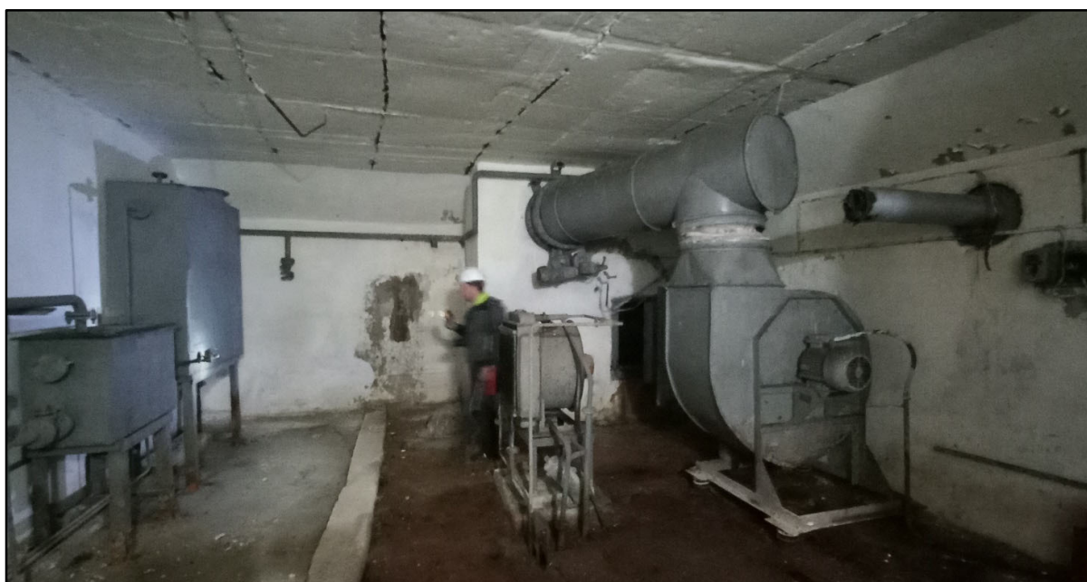
Фото 4. Общий вид помещения в осях 37-38/Ж-К
