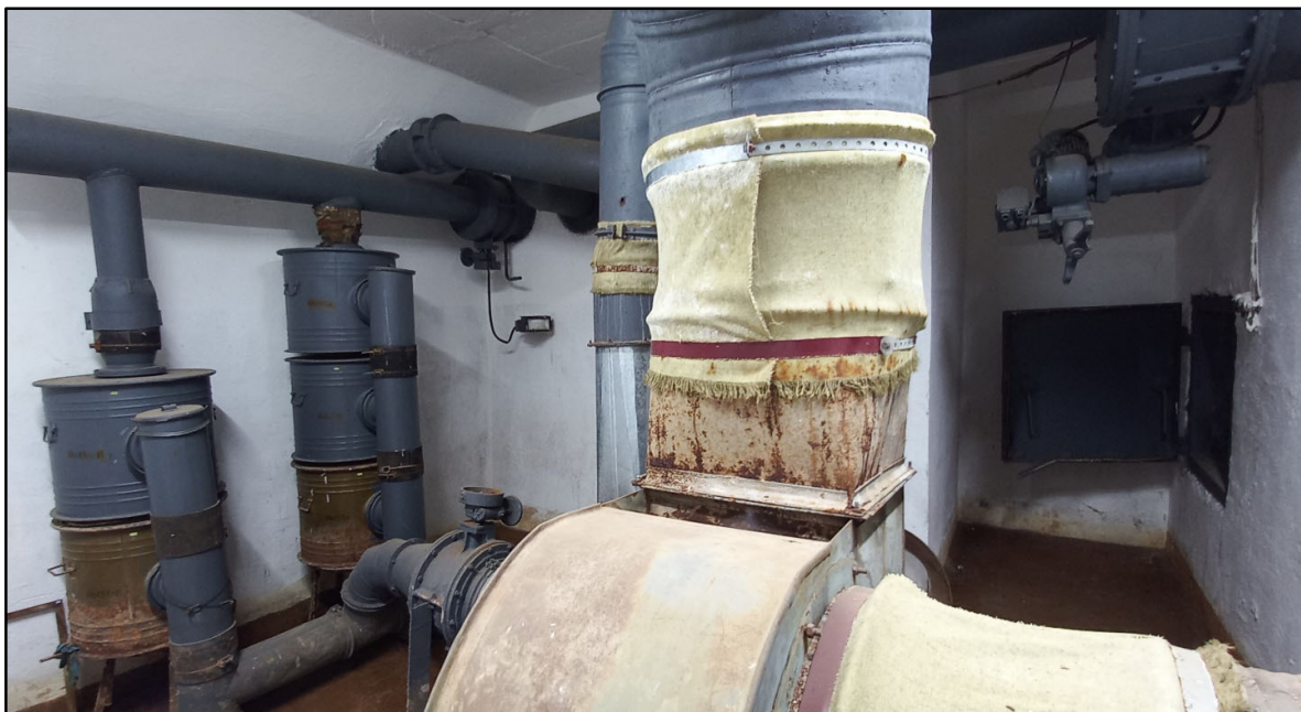
Фото 5. Общий вид помещения в осях 37-38/Д-Е
