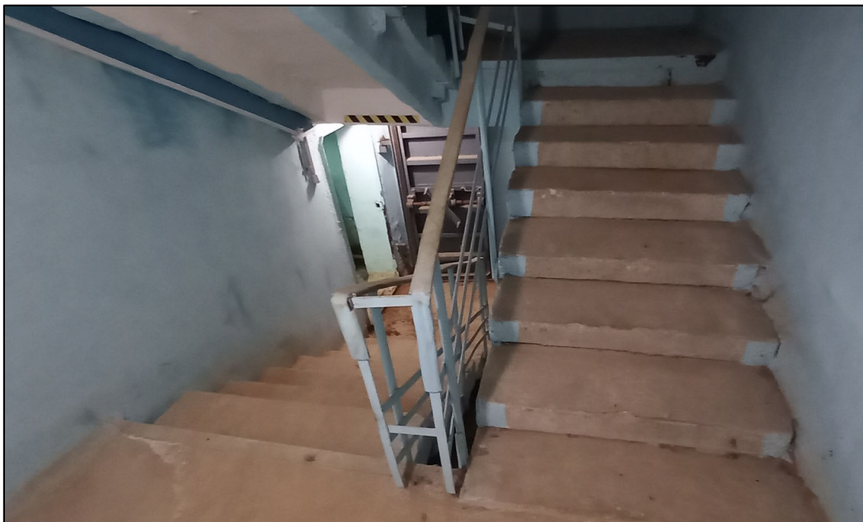
Фото 8. Общий вид входной группы в осях 37-38/Г-Д
