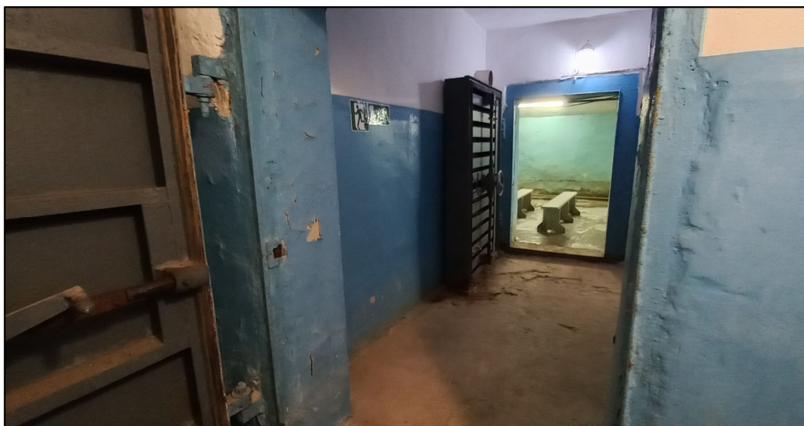
Фото 9, 10. Общий вид входной группы в осях 37-38/Е-Ж
